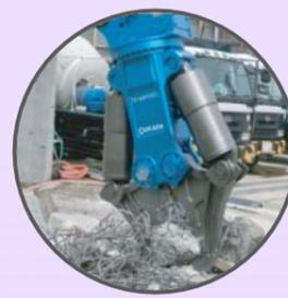
鉄筋コンクリート構造物を解体する一次破碎作業に使用します。
